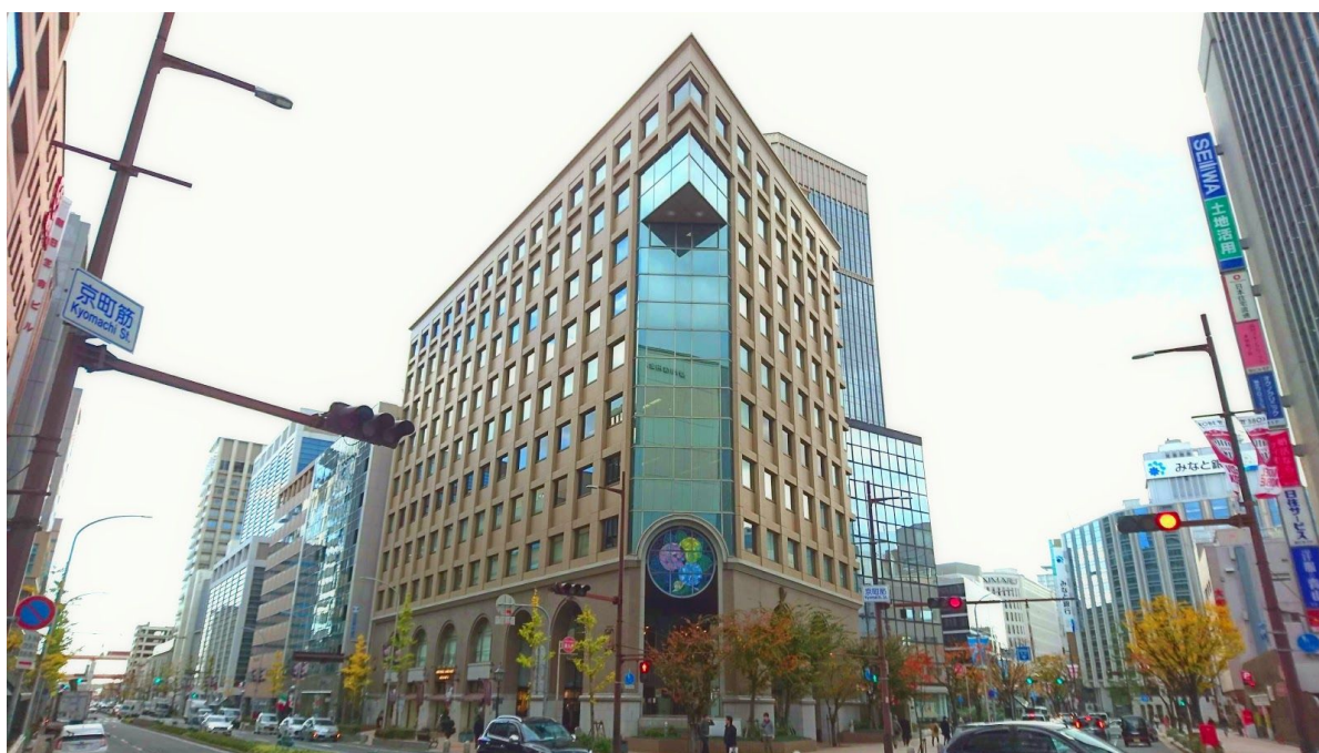
■神戸支店、新クレセントビル外観
